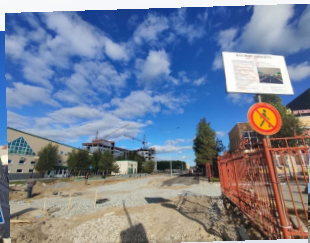
Строительство районной больницы гп. Пойковский
